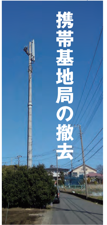
高いアンテナを撤去する
